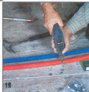
Трубопроводы закрепляют хомутками, привинчиваемыми к черному полу. Теперь отопительную батарею можно снова снять, ...
