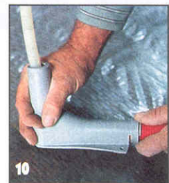
Введя защитную оболочку до упора, трубу сгибают, надевая на направляющее колено стопорное кольцо.
