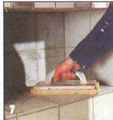
6 После короткой выдержки облицованную поверхность очищают с помощью увлажненной терки, подбитой губкой.
