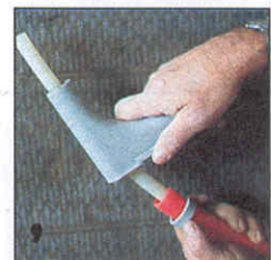
На оболочку трубопровода надевают стопорное кольцо, внутреннюю трубу вводят в башмак.
