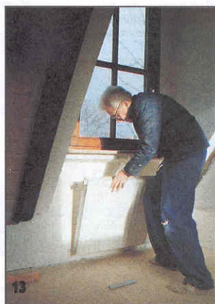
Закрепленные таким образом колена устанавливают на соответствующие выходы вентиля, подсовывают под них трубы и привинчивают к полу трубные башмаки.
