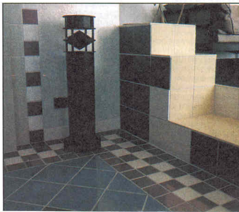
2 Выбранный рисунок покрытия проверяют, раскладывая плитки насухо.
