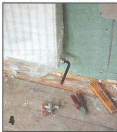
4 Пользуясь ключом, с другой стороны батареи внизу ввинчивают насадку с внутренним шестигранником.
