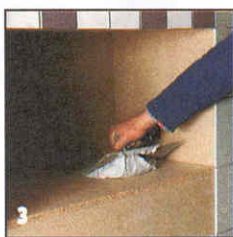
3 При облицовке поверхностей полки плиткой используют дисперсионный клей, который наносят зубчатой кельмой.
