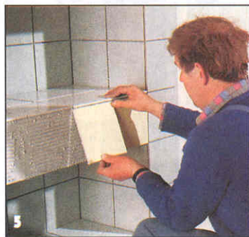
5 Сначала облицовывают горизонтальные поверхности полки, затем — ее заднюю и боковые вертикальные стенки.
