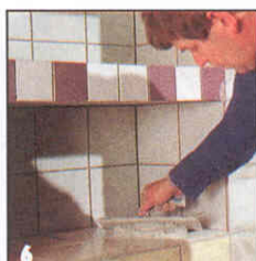
4 Когда клей затвердеет, можно приступить к затирке швов.
