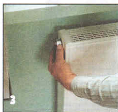
3 В верхнюю часть батареи ввертывают вентиль для выпуска воздуха, внизу ставят заглушку.
