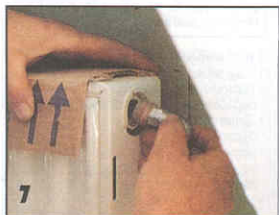
7 ... затем затягивают ключом.
