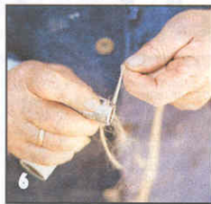
6 Верхнее соединительное колено уплотняют льном, наматывая его на резьбу, ...
