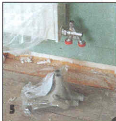
5 К насадке крепят вентиль для подающего и обратного трубопроводов. Его положение необходимо выверить по вертикали.
