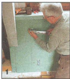
1 Отопительную батарею подвешивают на четыре кронштейна, которые крепят к стене шурупами Ø 10 мм с головкой под ключ.
