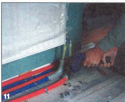
Закрепленные таким образом колена устанавливают на соответствующие выходы вентиля, подсовывают под них трубы и привинчивают к полу трубные башмаки.
