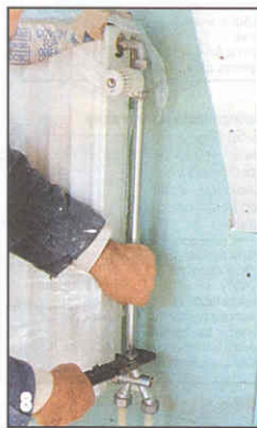
8 К установленному сверху вентилю термостата подгоняют трубу, к которой присоединяют соединительный узел для подключения трубопроводов.
