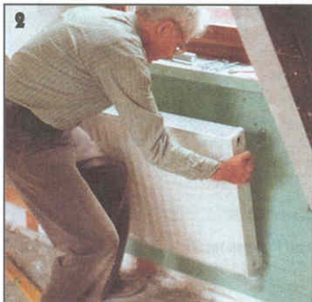
1 Отопительную батарею подвешивают на четыре кронштейна, которые крепят к стене шурупами Ø 10 мм с головкой под ключ.
