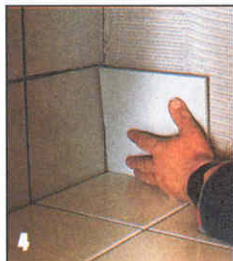
5 Сначала облицовывают горизонтальные поверхности полки, затем — ее заднюю и боковые вертикальные стенки.
