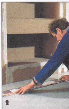
2 Выбранный рисунок покрытия проверяют, раскладывая плитки насухо.
