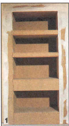
1 Дверную нишу реконструировали под шкаф, используя ДСП.
